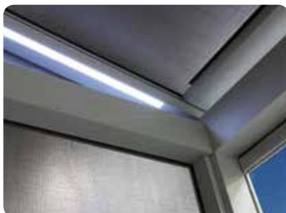
Eclairage LED intégré dans les coulisses du Rooffix de la **Lagune**.
